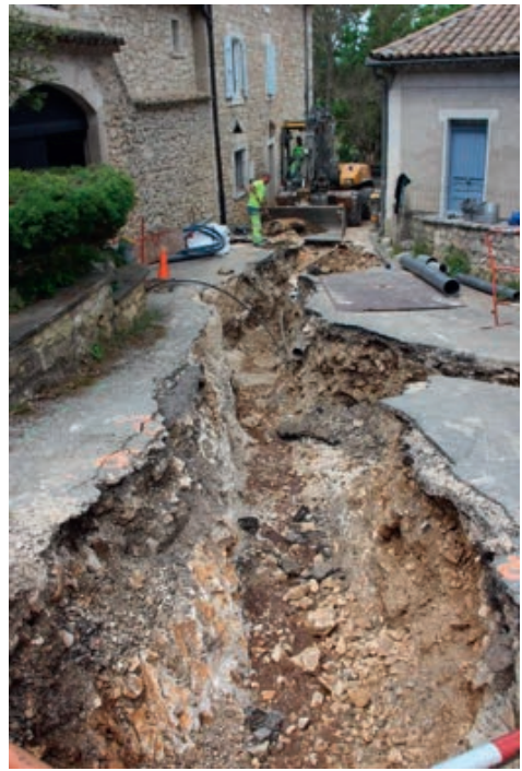
Tranchée rue du Porche
